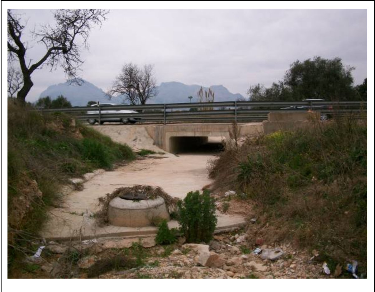
Vista desde aguas abajo del paso de la carretera N-332. ALF-107
