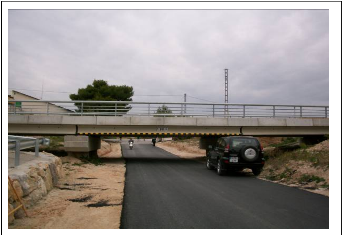
Vista del paso del ferrocarril Alicante – Denia desde aguas abajo. ALF-103
