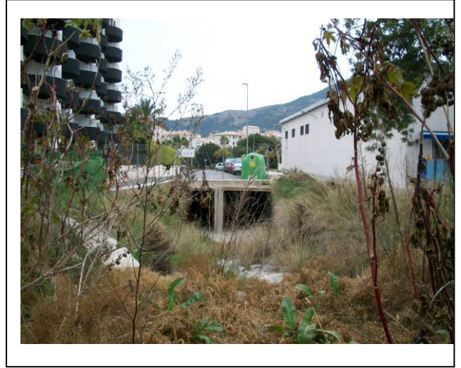
Vista del paso inferior de la rotonda de confluencia mediante un marco doble. ALF-101
