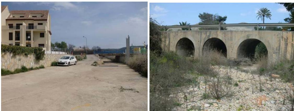
**Fotos 32 y 33: Muro a recrecer en 1,5 metros para proteger viviendas anexas al barranco del Cau en Llíber. A la derecha puente sobre barranco de Masserof en CV-750.**
