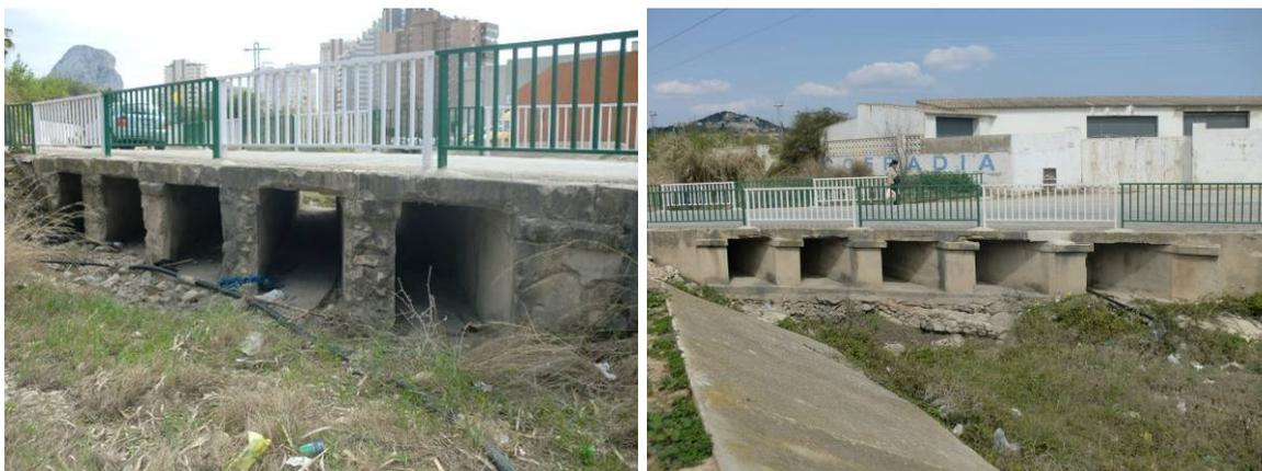
**Foto 12 y 13: Puente bajo la Avenida de los Ejércitos, desde aguas arriba y abajo respectivamente donde se aprecia la dificultad para su drenaje y lo fácilmente que puede obstruirse.**
