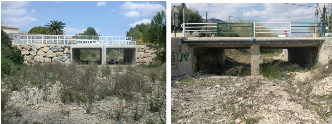
**Foto 10 y 11: Puentes de la Partida Gargasindi donde se observa la reducción que suponen los cajones respecto a la anchura del cauce. A la derecha puente de la avenida Casanova parcialmente aterrado, ambos sobre el barranco del Pou Roig.**
